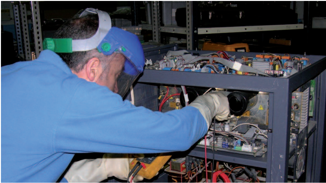
El accidente eléctrico puede presentarse por contacto directo con partes activas (en tensión) de la instalación
